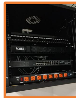
AVANCE EN INSTALACIÓN DE CANALETAS, INSTALACIÓN DE CAJAS ELECTRICAS, CABLEADO, GABINETES Y SWITCHS, PENDIENTE INSTALACION DE UPS Y CONFIGURACIÓN
