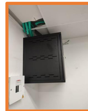
AVANCE EN INSTALACIÓN DE CANALETAS, INSTALACIÓN DE CAJAS ELECTRICAS, CABLEADO, GABINETES Y SWITCHS, PENDIENTE INSTALACION DE UPS Y CONFIGURACIÓN
